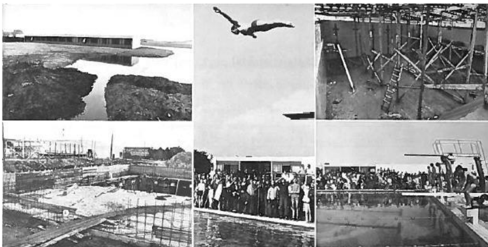
Før arbejdet begynde Rejsegildet
